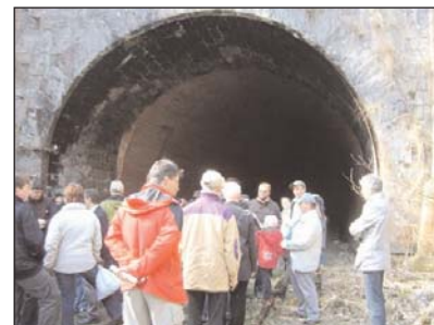
Vor dem Küllstädter Tunnel versammelten wir uns, um in absoluter Dunkelheit des Tunnels das Licht der Auferstehung zu erahnen.
